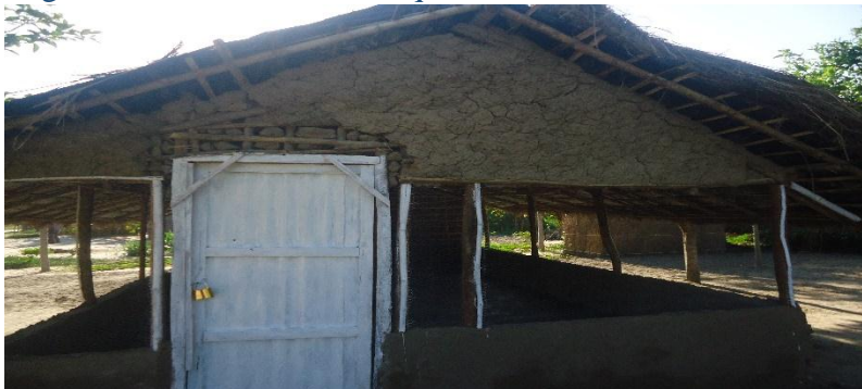
Fig. 12 Pavilhão de Pau a Pique com malha metálica
